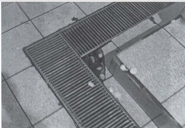
ZONA DE REJILLAS A SER REFACCIONADAS Y ADECUADAS AL PISO STONHARD
