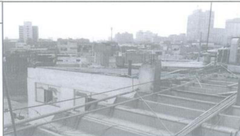
AL FONDO DE LA IMAGEN DEL TECHO SE APRECIA CONCRETO DE LA COLUMNA DESPRENDIDO A DEMOLER PUES REPRESENTA UN RIESGO LATENTE.
