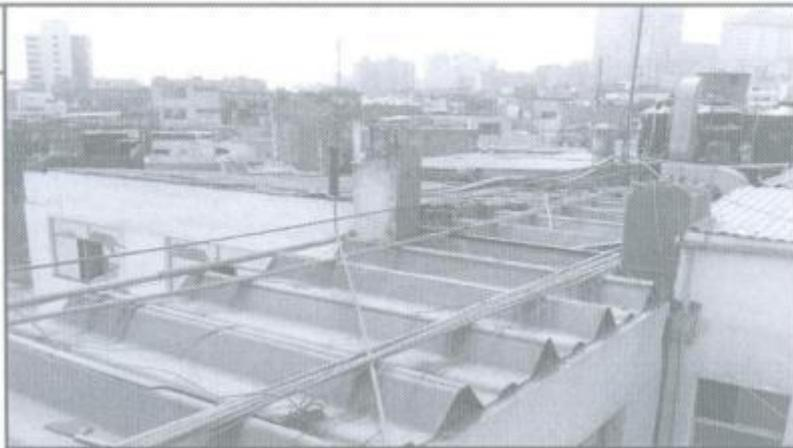
VISTA PANORÁMICA, DE LA COBERTURA DE CENTRAL DE ESTERILIZACIÓN. SE APRECIA DESNIVEL INTERNO DEL TECHO, CON COBERTURAS DETERIORADAS POR EL TIEMPO.
