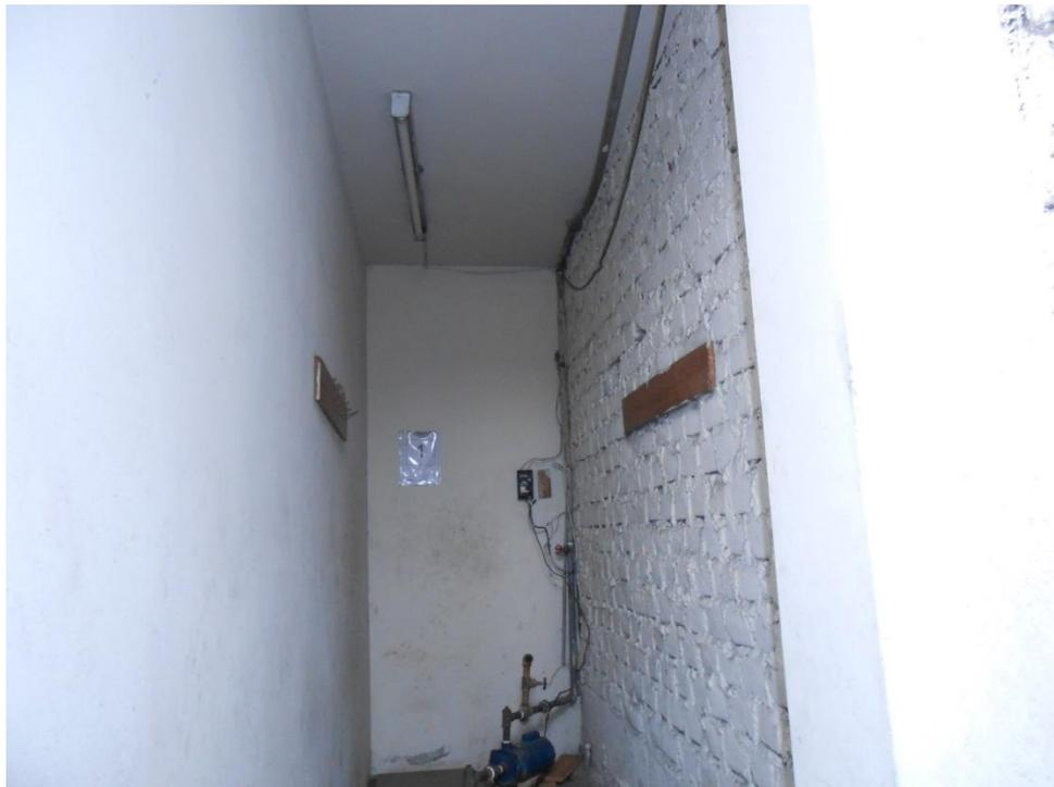
ELECTROBOMBA Y LINEA DE IMPULSION A TANQUE ELEVADO PREFABRICADO
