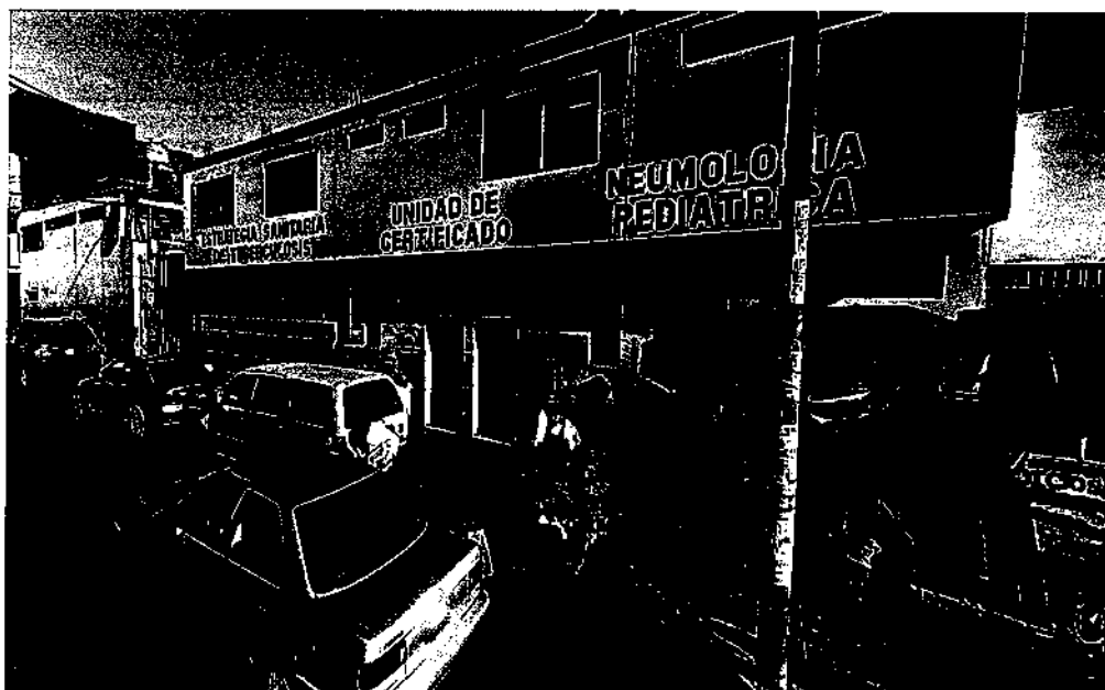
FOTO 3: EDIFICIO ANEXO (VISTA JR. CHOTA)
