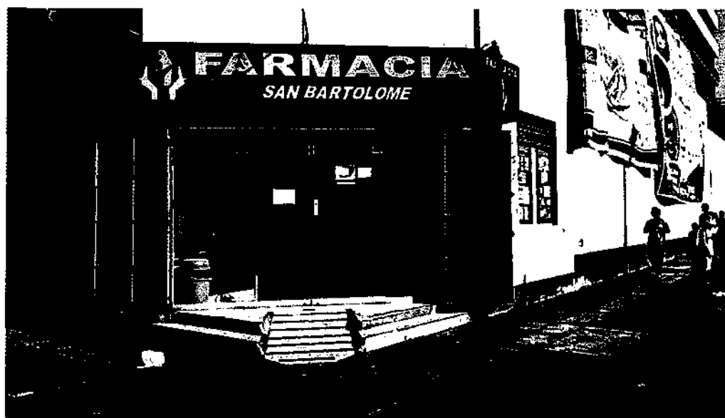
FOTO 4: EDIFICIO ANEXO (ESQ. AV. ALFONSO UGARTE Y JR. CHOTA)
