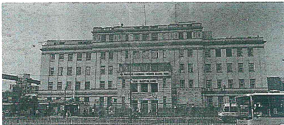
Fachada Av. Alfonso Ugarte
